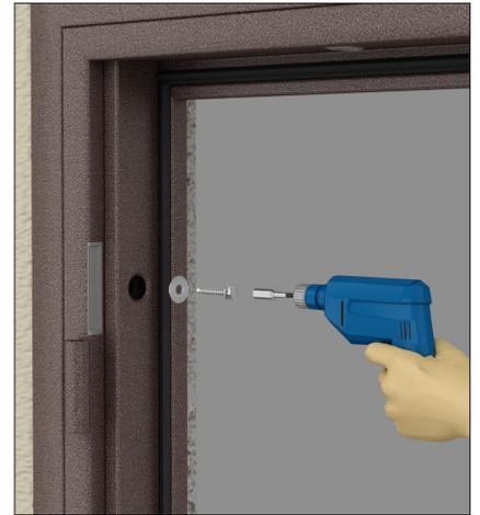
В просверленные отверстия закрутите саморезы по металлу с шайбой при помощи биты.
