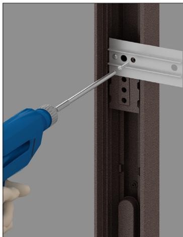
Закрепите монтажные пластины при помощи саморезов на раму под углом 90° через отверстия в анкерной пластине.
