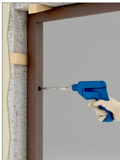
Просверлите 8 отверстий в проеме глубиной 100-150 мм через отверстия в раме.
