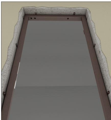
Установите раму в проем. Выставьте раму по уровню, фиксируя ее в проеме при помощи распорных клиньев. Монтажные пластины должны плотно прилегать к проему для надежной фиксации коробки. Технологический зазор между рамой и полотном должен быть равномерным.
