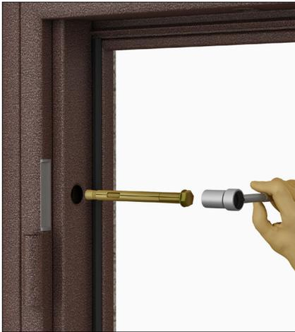
В просверленные отверстия установите анкерные болты/нагили и затяните головкой/ключом типа торекс.
